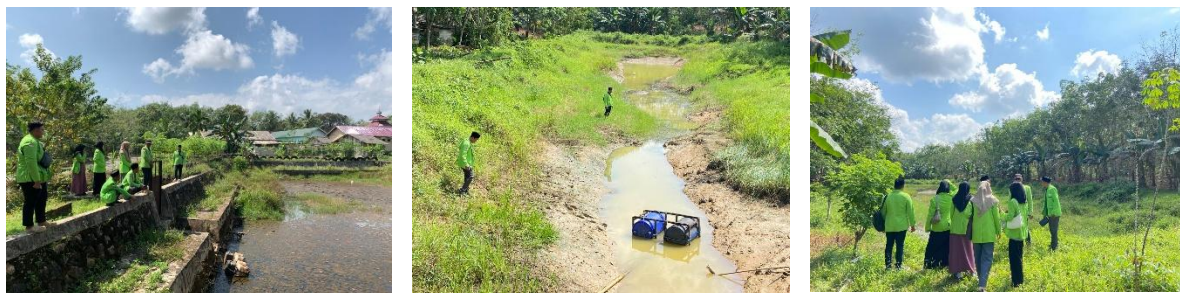
Gambar 1. Survey Kondisi Embung Desa Indraloka Jaya
