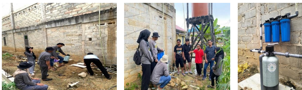
Gambar 4. Pemasangan Alat Filtrasi
