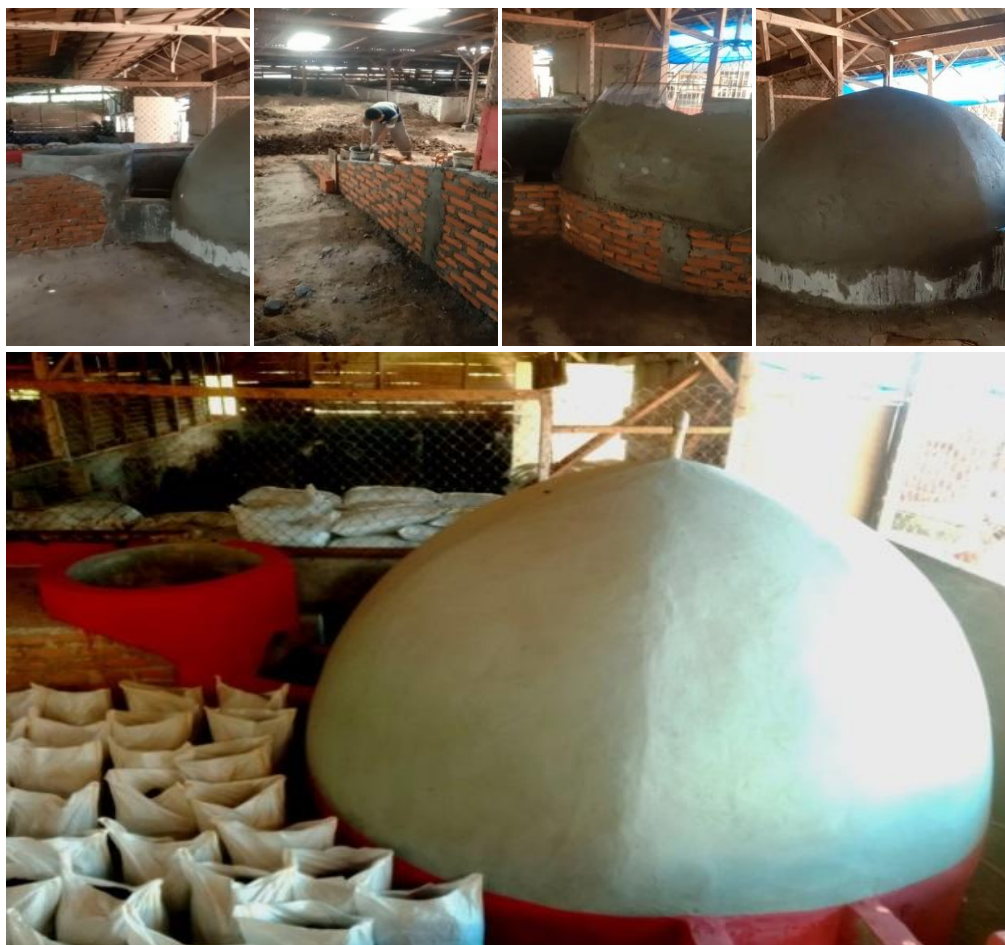
Gambar 4. Bantukan akhir biodigester tipe fixed dome siap pakai
