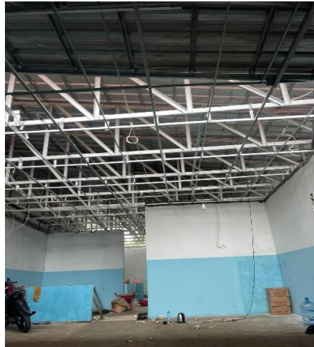
Gambar 5. Kondisi Proyek Konstruksi Gedung - Struktur Rangka Atap
