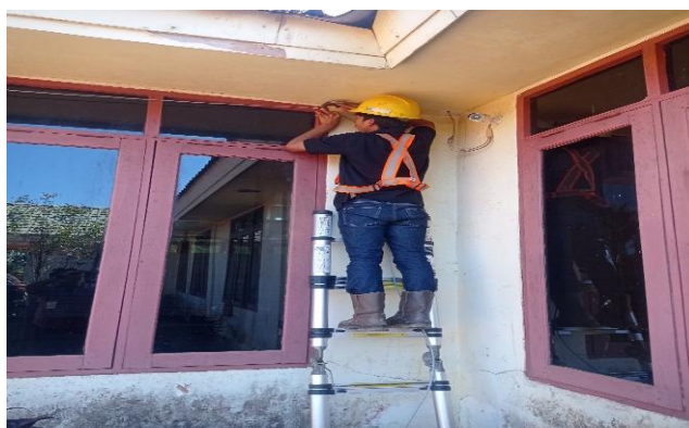
Gambar 2. Pemasangan dan Perbaikan Access Point
