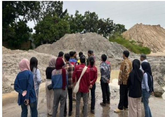
Gambar 3. Identifikasi dan pengambilan sampel limbah berasal dari fasilitas batching plant dan Asphalt Mixing Plant (AMP)
