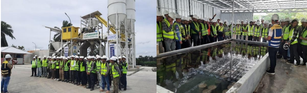
Gambar 2. Koordinasi antara ITERA dengan pihak Mitra Pengabdian Kepada Masyarakat (PKM) dengan peninjauan langsung lapangan di tempat produksi Batching Plant dan Asphalt Mixing Plant
