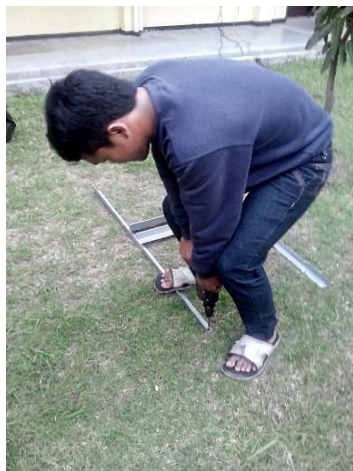
Gambar 3. Persiapan untuk tempat solar panel
