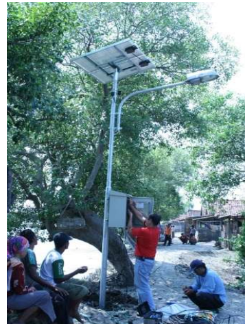
Gambar 4. Pengukuran lampu penerangan yang menggunakan solar panel
