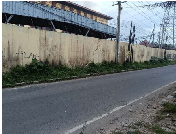
Gambar 7. Kondisi Drainase Jalan Senopati saat tidak terjadi hujan
