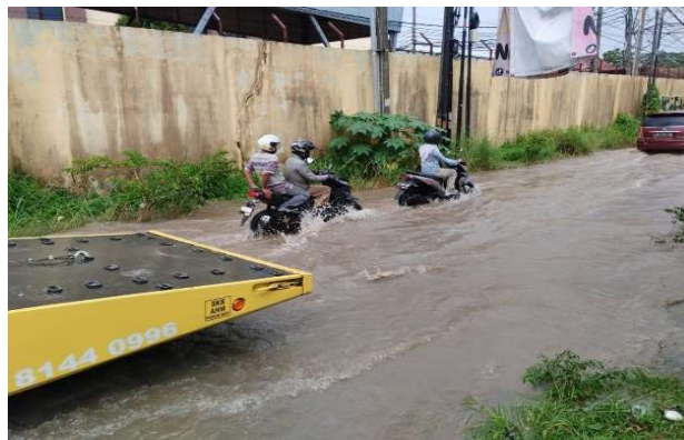
Gambar 6. Kondisi lokasi saat kejadian banjir akibat limpasan hujan meluap dari drainase dan menggenangi jalan raya
