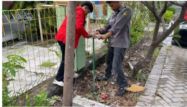
Gambar 4. Pemasangan Biopori
