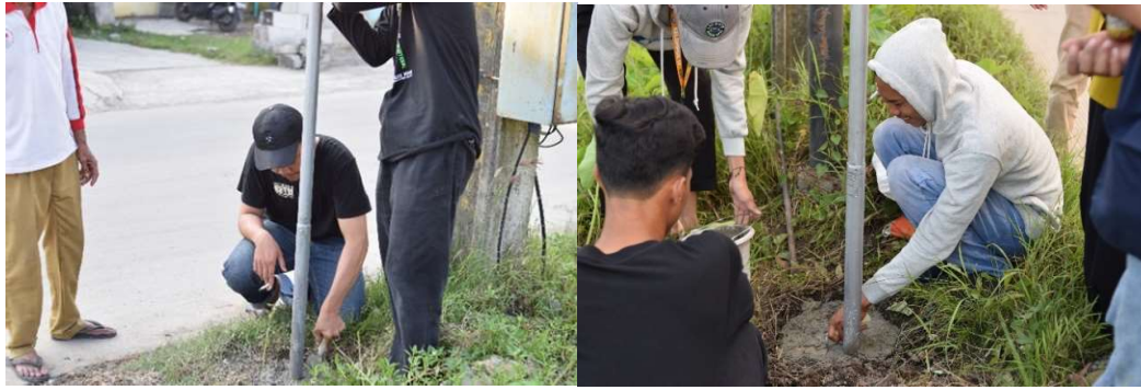
Gambar 9 Pengecoran Rambu Jalan
