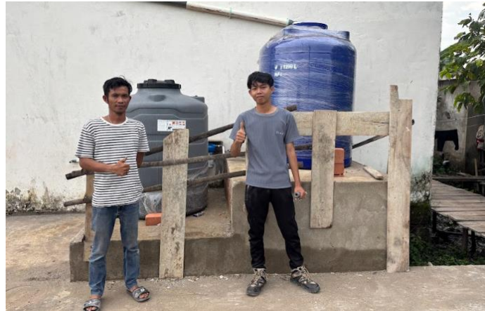
Gambar 10. Sistem pengolahan air hujan telah selesai dibangun
