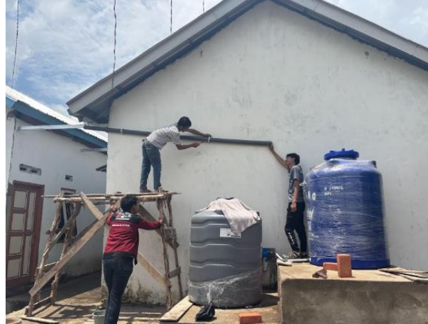
Gambar 8. Proses Pembangunan filtrasi air hujan
