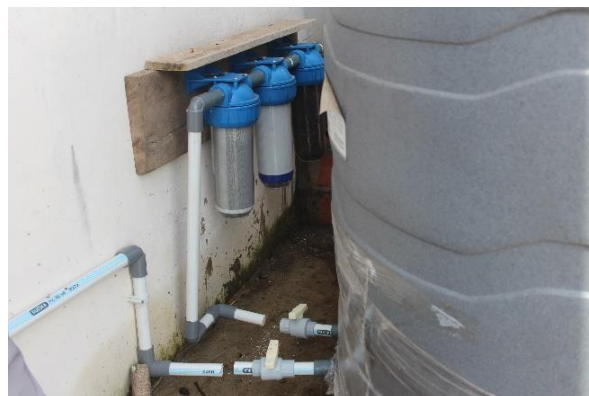
Gambar 7. Sistem filtrasi modern dengan media PP, CTO, dan GAC
