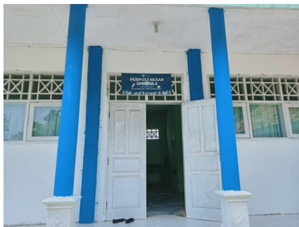
Gambar 7. Kondisi Perpustakaan Sesudah dilakukan Pengecatan
